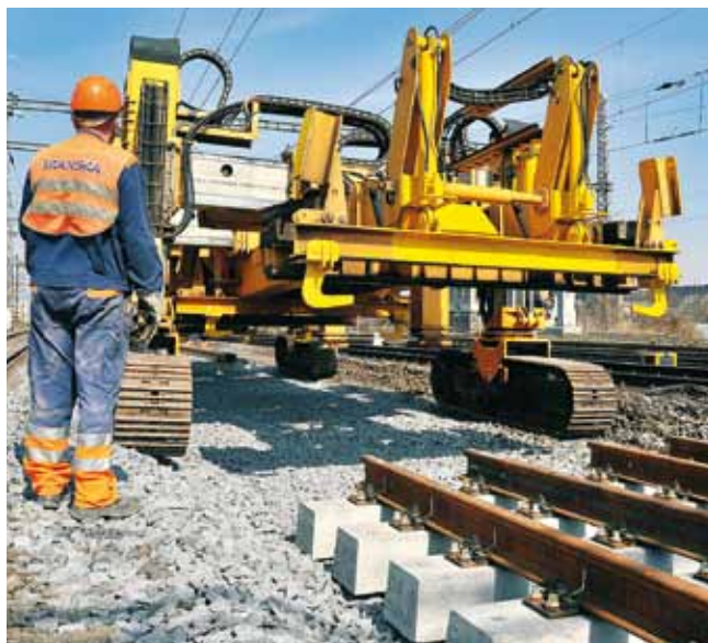
Pokládka nových kolejových polí
