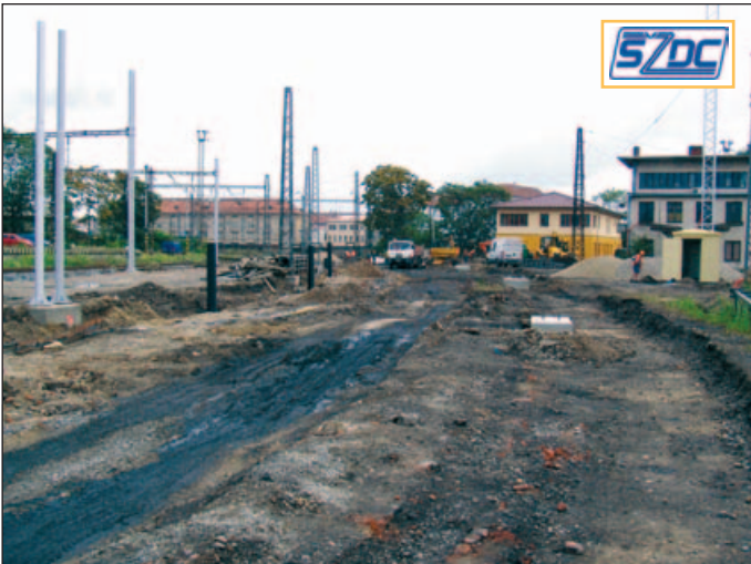
Vytrhané koleje a výhybky ve směru na Negrelliho viadukt. Vpravo stávedlo místního dozoru, které se bude bourat, vlevo nová stavba ústředního stávedla.
