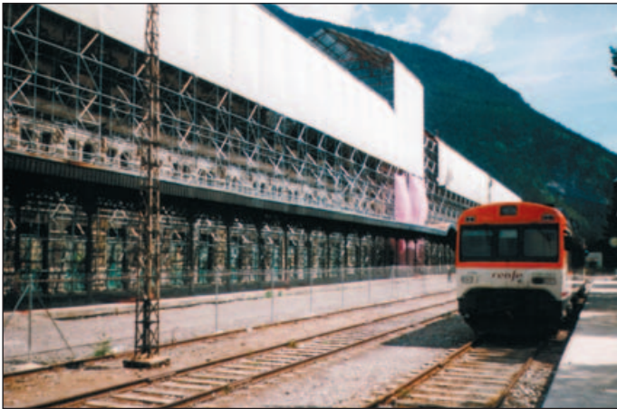
Dvakrát denně zavítá na nádraží Canfranc motorový vlak španělských železnic RENFE. Na pozadí mohutné nádražní architektury působí až titěnně. Foto: AUTOR (4x)
