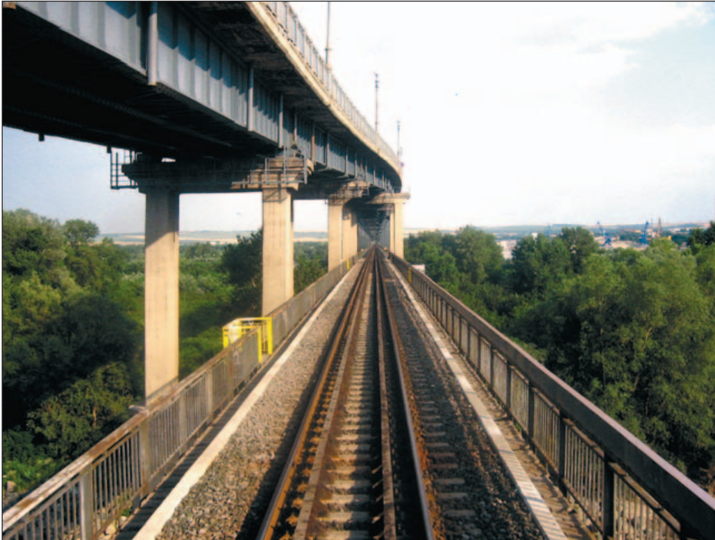
Víte, jak vypadá most, to celé na druhou? Jeden takový stojí na rumunsko-bulharské hranici mezi stanicemi Giurgiu Nord a Ruse. Mnohý železniční cestovatel si jistě tento most pamatuje ze svých toulek, neboť se zde vlaky „sprchují“ dezinfekcí, která je ve voze cítit ještě nejméně půl hodiny. Autorkou zdařilého fotopostřehu je tentokrát Ludmila Ovesná ze Vsetína.
