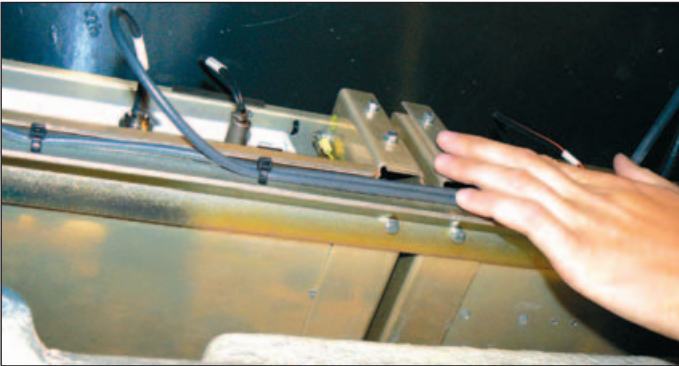
Část ovládací skříňky zesilovače v prostoru mezi střechem a stropem oddílů pro cestující. Foto: AUTOR
