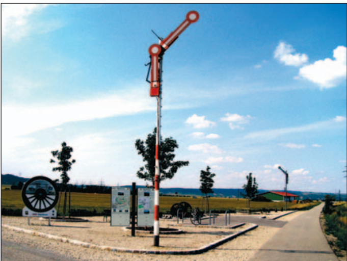
Jedno ze zastavení na cyklotrase vedoucí po bývalé lokální dráze. Stojany na kola a lavičky jsou doplněny informačními tabulemi a řadou železničních artefaktů připomínajících historii železnice.
